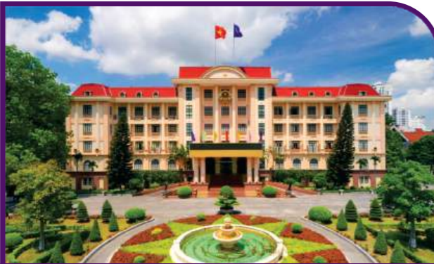
UBND tỉnh Bắc Giang People's Committee of Bac Giang province
